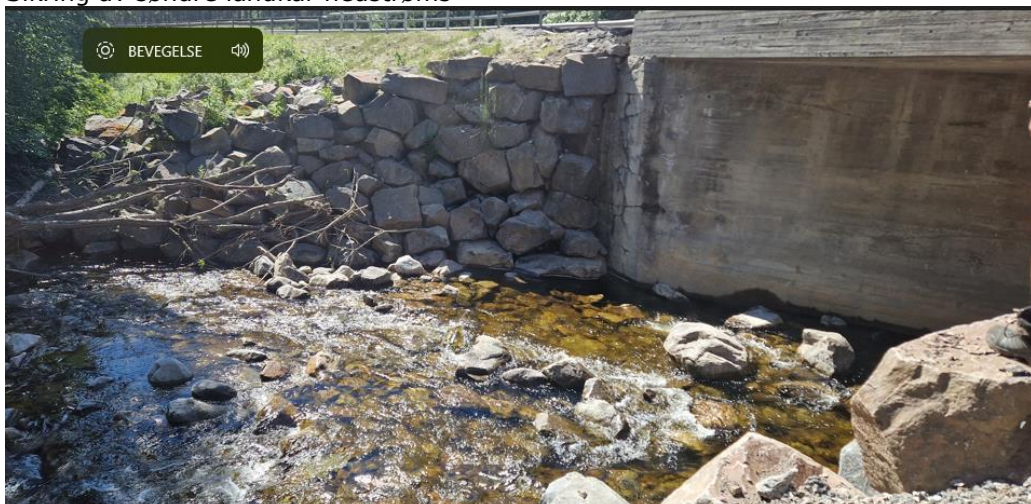
Sikring av søndre landkar nedstrøms
