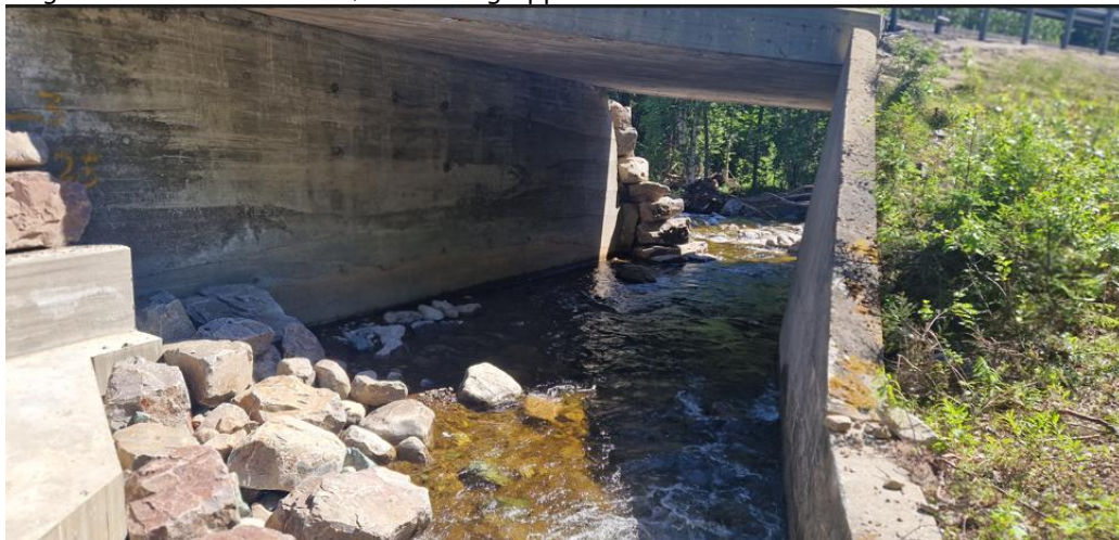
Dagens bru sett fra nedstrøms bru og oppover
