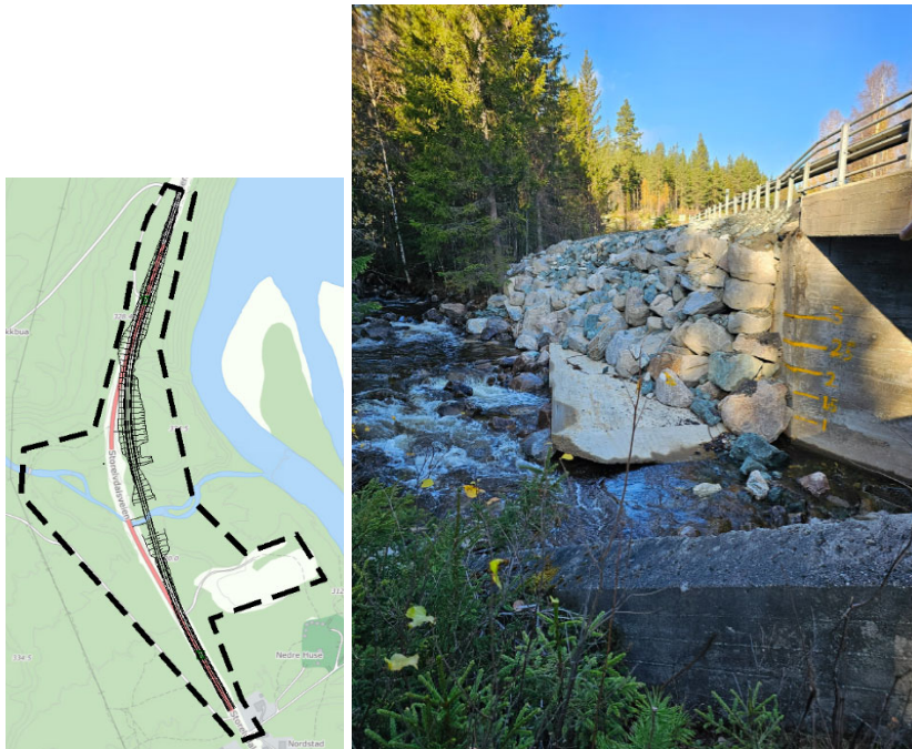
Figur 1 viser planområdet for rv. 3 Søre Bjøråa bru, bilde til venstre vinge i elva og steinsetting over.
