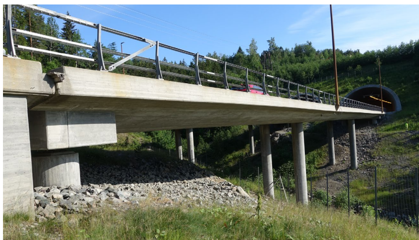
Eksempel, Labbdalsbrua, E6 i Stange, 2023, Statens vegvesen
