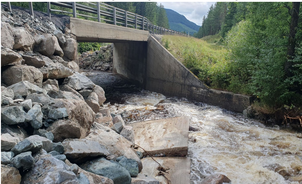
Bilde av Søndre Bjøra bru i 2023, Statens vegvesen
