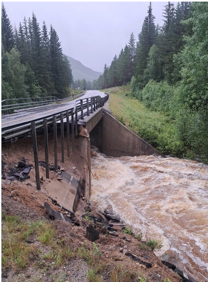
Bilde fra 2023-08-09 da ekstremværet Hans medførte ras i en oppstrøms vinge og tilløpsfyllingen, Statens vegvesen
