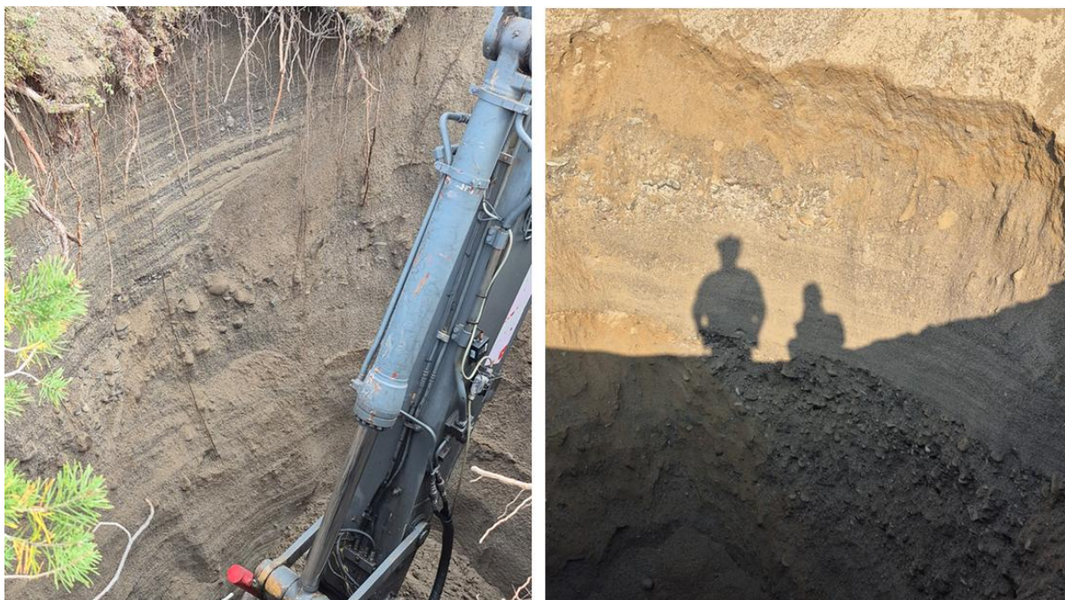
Figur 4.3: Bilder tatt ved prøvegravingen 09.09.2025. Prøvegrop i punkt 2 (venstre) og prøvegrop i punkt 3 (høyre) som viser lagdelte masser med fin sand og grus.
