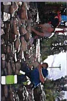
Hvelvsteinene låses med såkalt pining. Taksitter fra gammelt løvetak er brukt. Foto: Cathrine Thorstensen / Norsk vegmuseum, Statens vegvesen.
