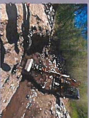
Nordre Kjemå bru var godt fundamentert på fjell, slik også E. Overgaard skriver. Foto: Cathrine Thorsensen / Norsk vegmuseum, Statens vegvesen.
