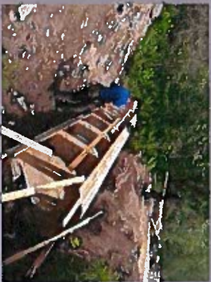
Hvelvsteinene låses med såkalt pining. Taksitter fra gammelt løvetak er brukt. Foto: Cathrine Thorstensen / Norsk vegmuseum, Statens vegvesen.
