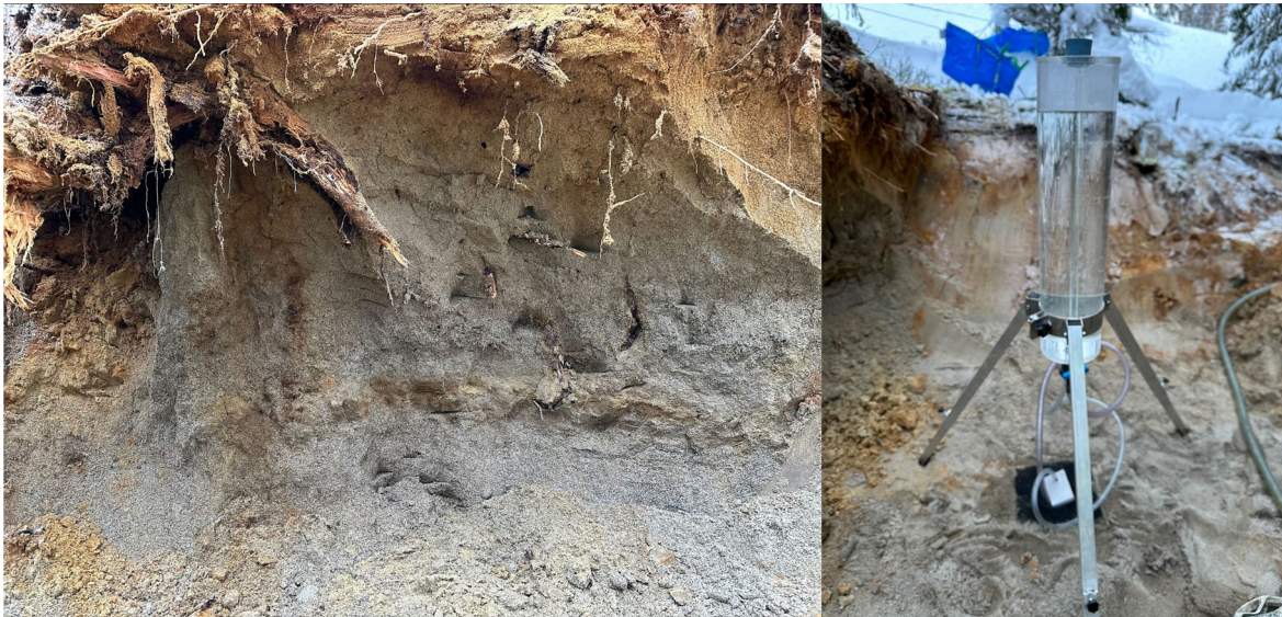
Figur 3-4: Bilder fra P2, der bildet til venstre viser nordre vegg i sjakta og bildet til høyre viser infiltrometeret installert i bunnen av sjakta på 1 m dybde.
