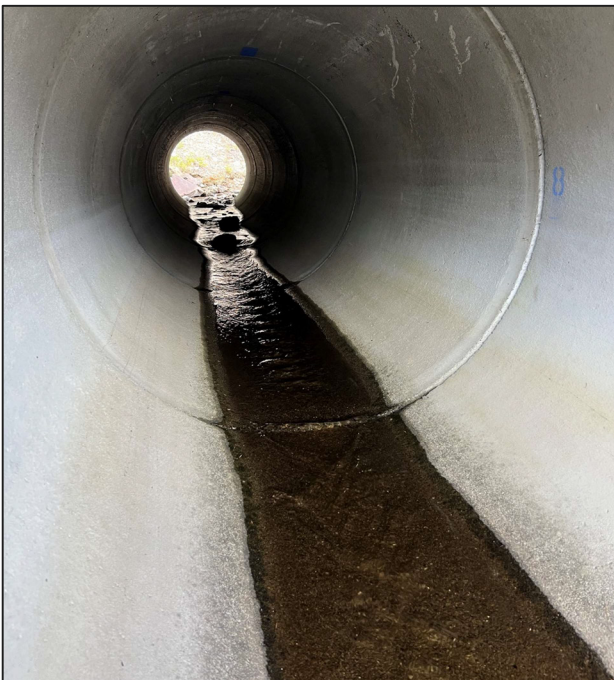
Figur 3-7. Stikkrenne under jernbanen med lav vanddybde, som er et vandringshinder for fisk. Foto: Sunniva Buvarp 29.04.2025.
