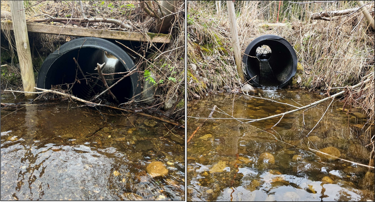
Figur 3-6. Stikkrenne under veg sett fra oppstrøms (venstre) og nedstrøms (høyre). Liten vanddybde og greiner som blokkerer innløpet i kulverten gjør fiskevandring utfordrende. Foto: Sunniva Buvarp og Johanna Skrutvold, 29.04.2025.
