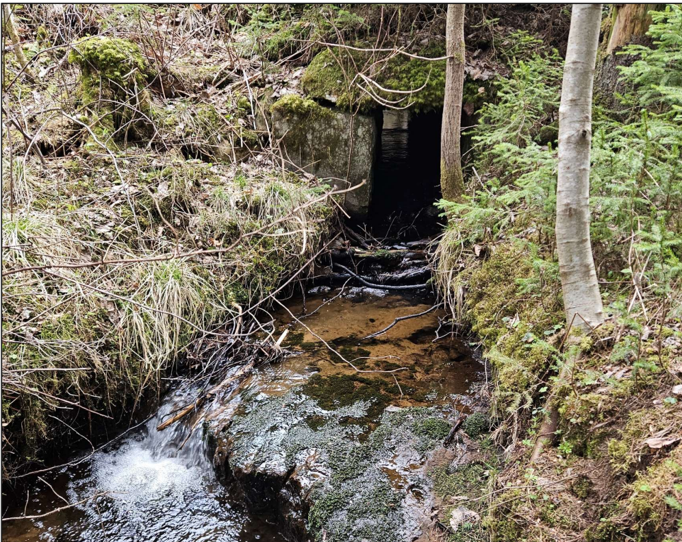
Figur 3-4. Kistekulvert under veg. Foto: Johanna Skrutvold, 29.04.2025.
