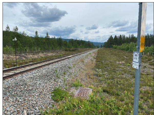
Figur 12: Bildet viser siktforholdene mot nord, der grusvegen inn til sandtaket krysser jernbanen.
