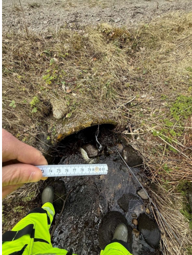
Figur 2-1 Til venstre: Stikkrenna som leder Siljubekken gjennom fv. 2188 har lite kapasitet. Til høyre: Bekken går over til vannspeil inn mot banefyllingen.
