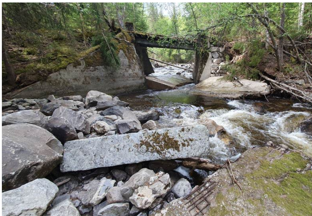
Bilde av brua i tidligere vestlig trase, 2024, Statens vegvesen
