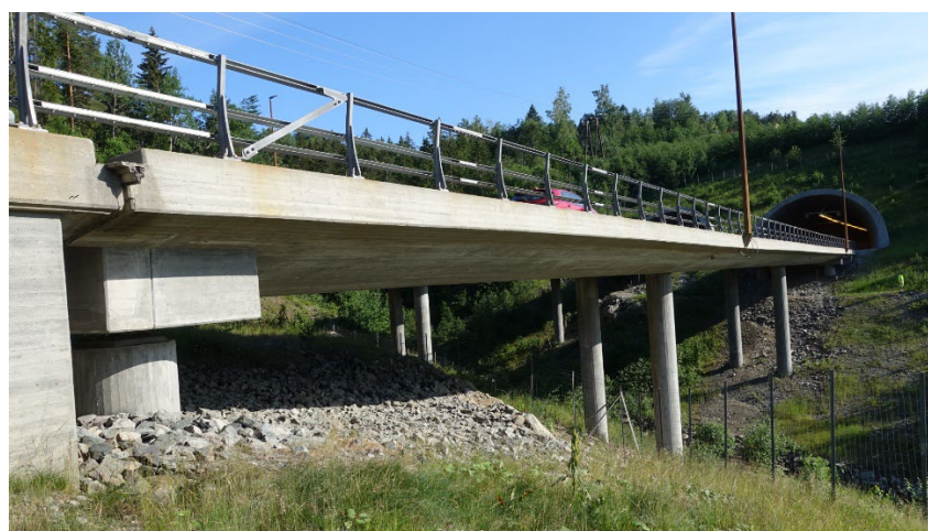
Eksempel, Labbdalsbrua, E6 i Stange, 2023, Statens vegvesen
