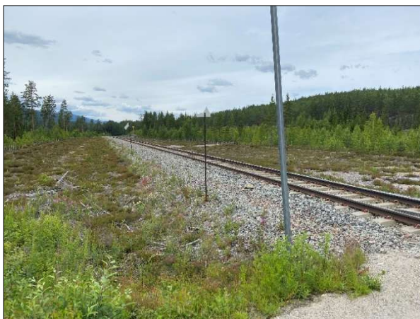
Figur 11: Bildet viser siktforholdene mot sør, der grusvegen inn til sandtaket krysser jernbanen.
