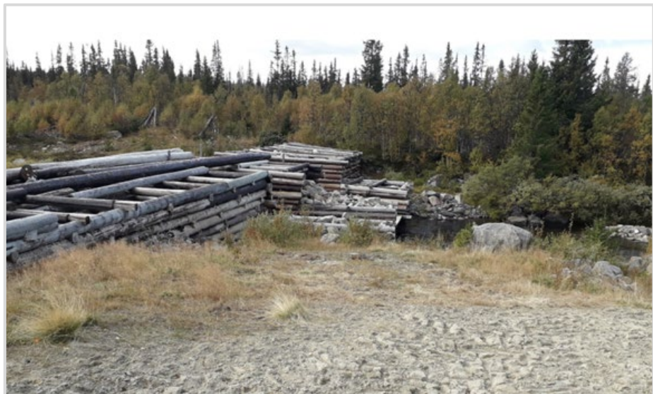
Figur 6.7: Damanlegget i Søkkunda, etter rehabilitering i 1997.
