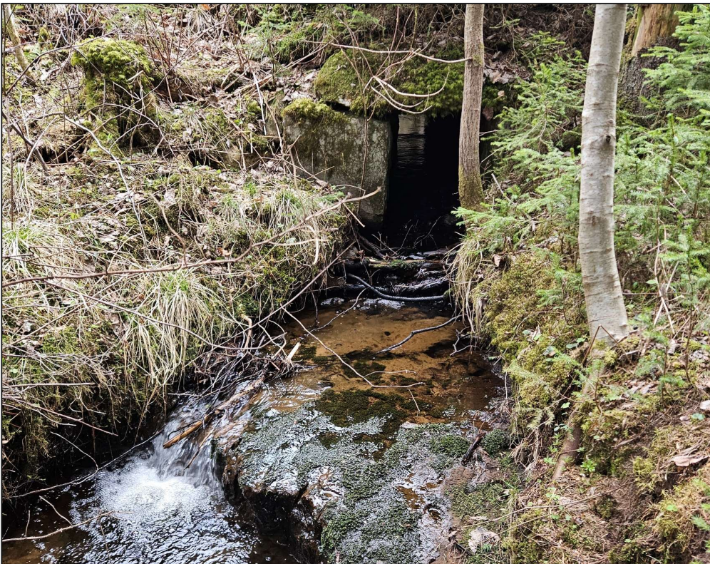
Figur 3-4. Kistekulvert under veg. Foto: Johanna Skrutvold, 29.04.2025.
