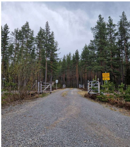
Figur 7 Planovergang ved km. 210,1
