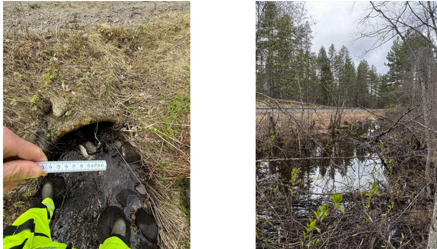
Figur 2-1 Til venstre: Stikkrenna som leder Siljubekken gjennom fv. 2188 har lite kapasitet. Til høyre: Bekken går over til vannspeil inn mot banefyllingen.
