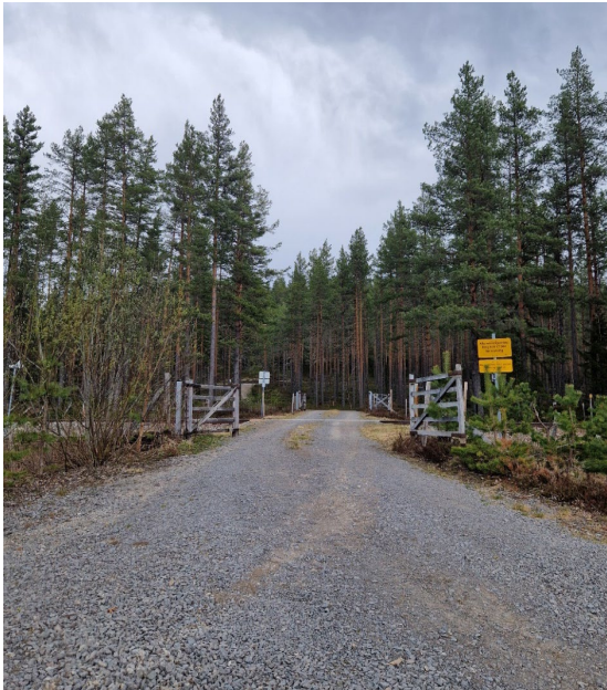
Figur 7 Planovergang ved km. 210,1
